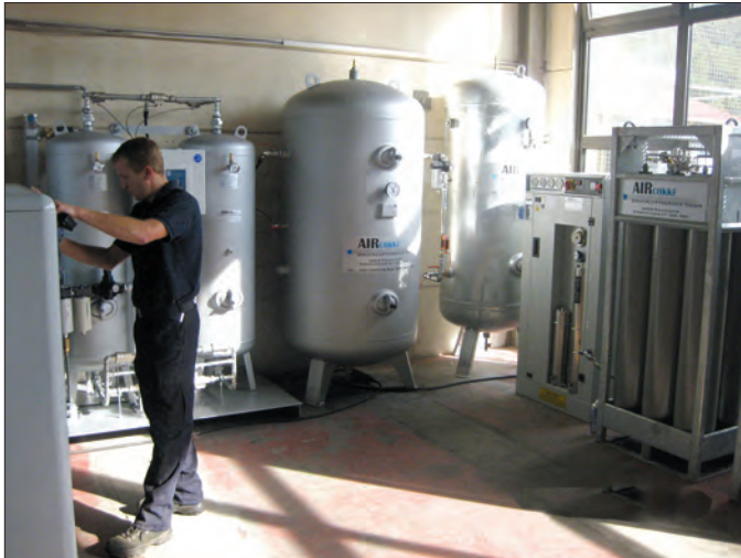
In praxi bewährt – die PSAL-Technik von AIRCO und INMATEC zur Eigenproduktion von Stickstoff für Laseranlagen ermöglicht Kostensenkungen von bis zu 60 Prozent
