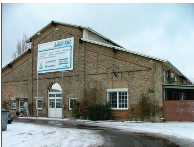
Hier entstehen technische Systeme zur Druckluft-, Stickstoff- und Sauerstofferzeugung: Unternehmenssitz der AIRCO SystemDruckluft GmbH in Frankfurt
